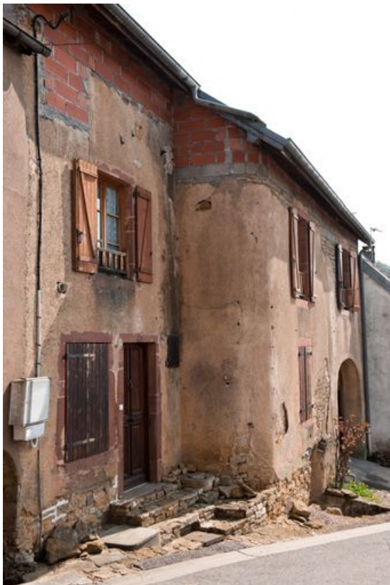
Façade antérieure, vue de trois quart gauche.
