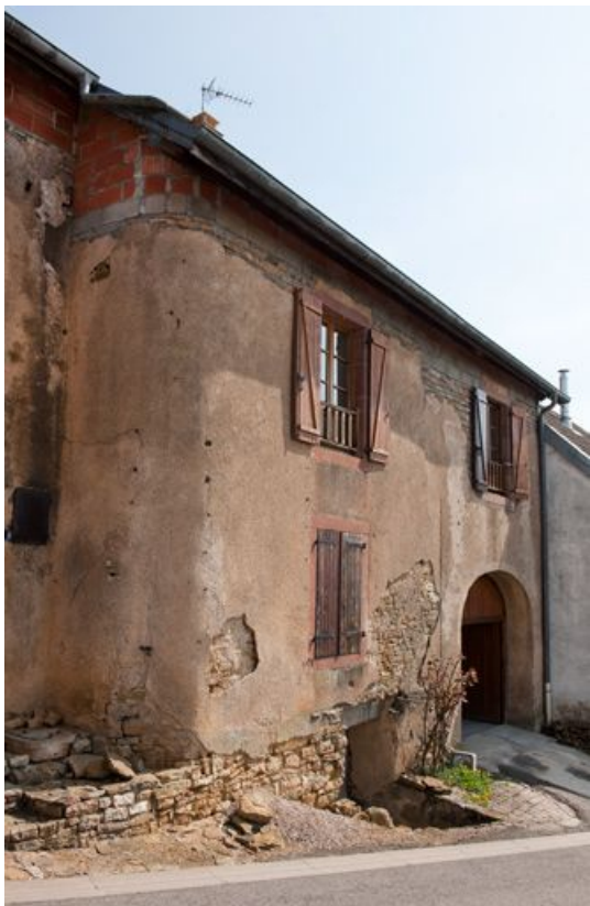
Vue rapprochée de la façade antérieure.
