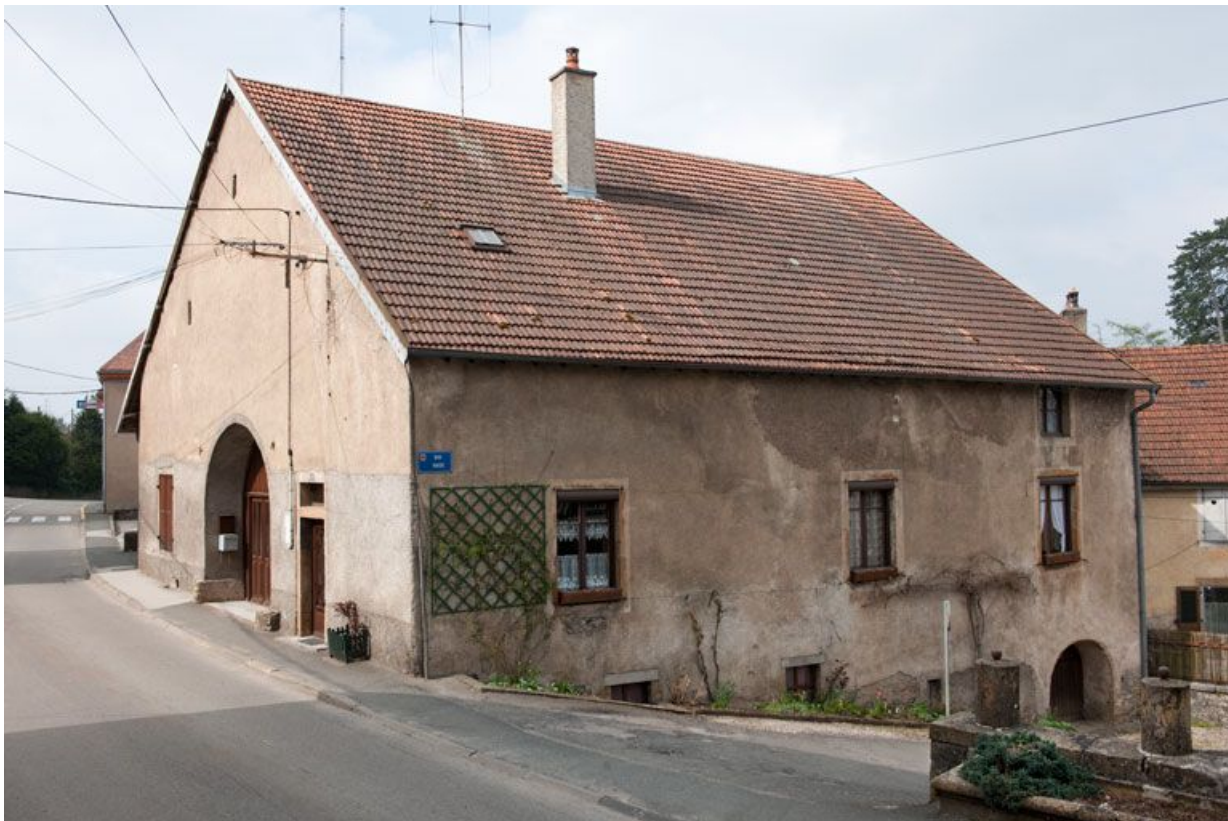
Façade antérieure et façade latérale droite.
