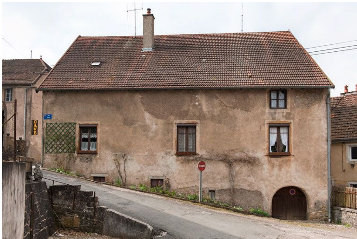
Façade latérale droite.
