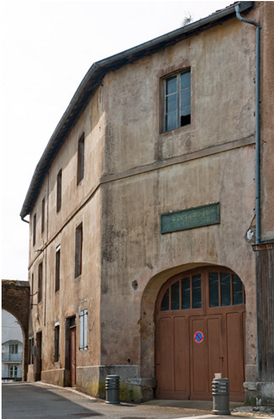
Vue générale de la façade antérieure.
