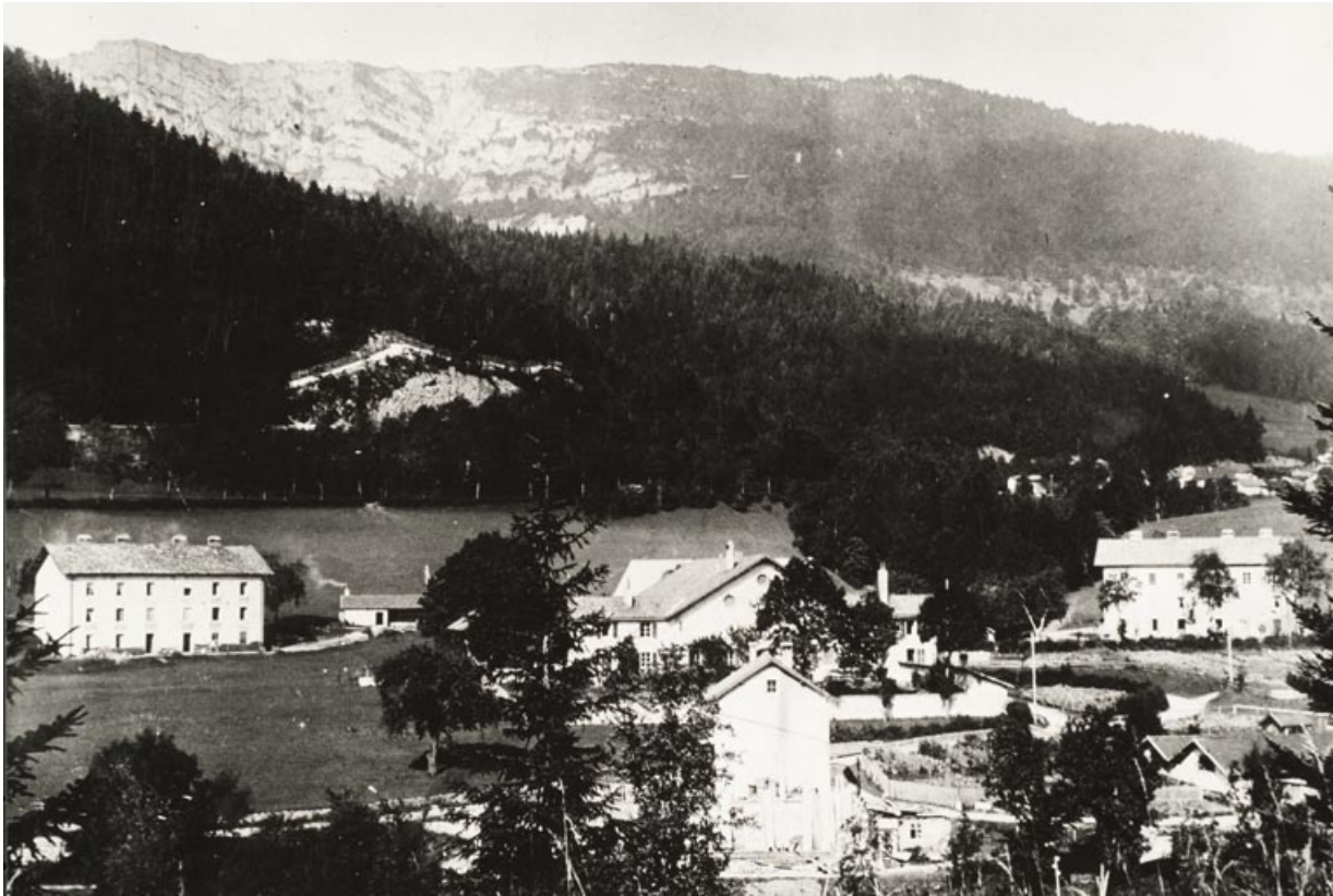
Vue générale après l'incendie de 1913
