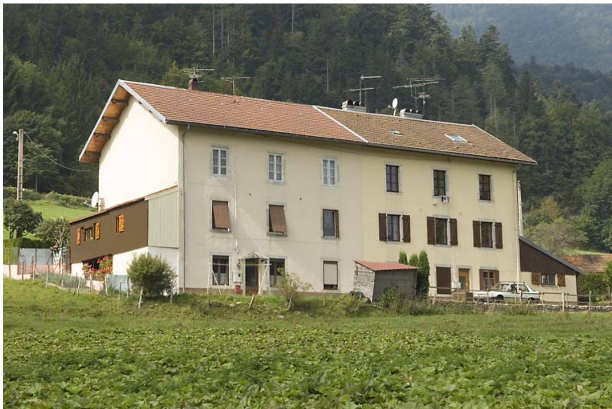
Immeuble à logements, façade postérieure.
