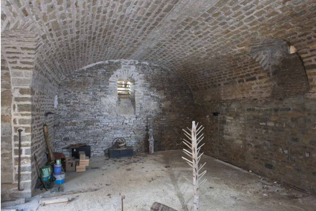
Vue générale d'une des caves des communs.
