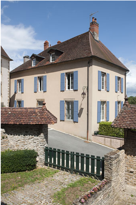
Vue générale depuis la cour des communs.
