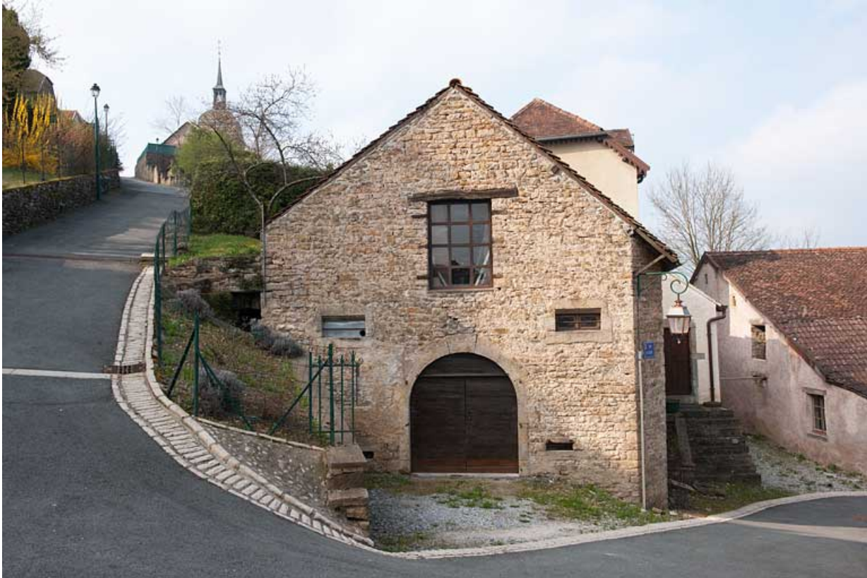
Grange : façade latérale gauche.
