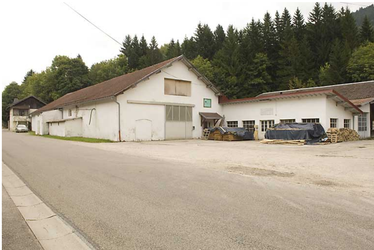
Partie nord du site : vue générale.
