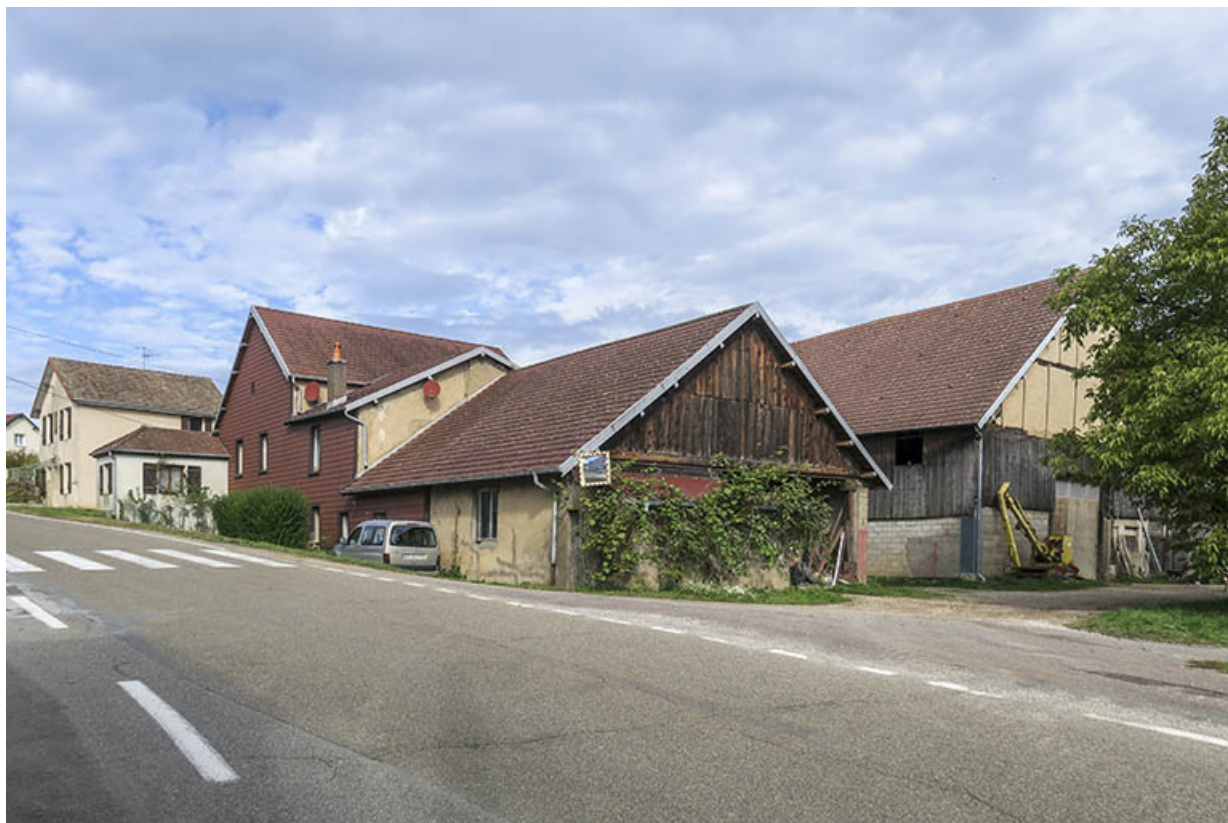
Vue d'ensemble, depuis le sud.
