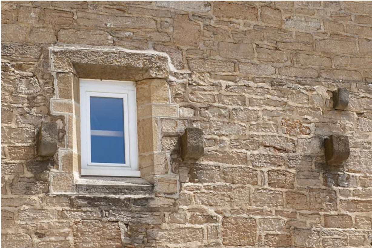
Chapelle (F), vue d'une baie.
