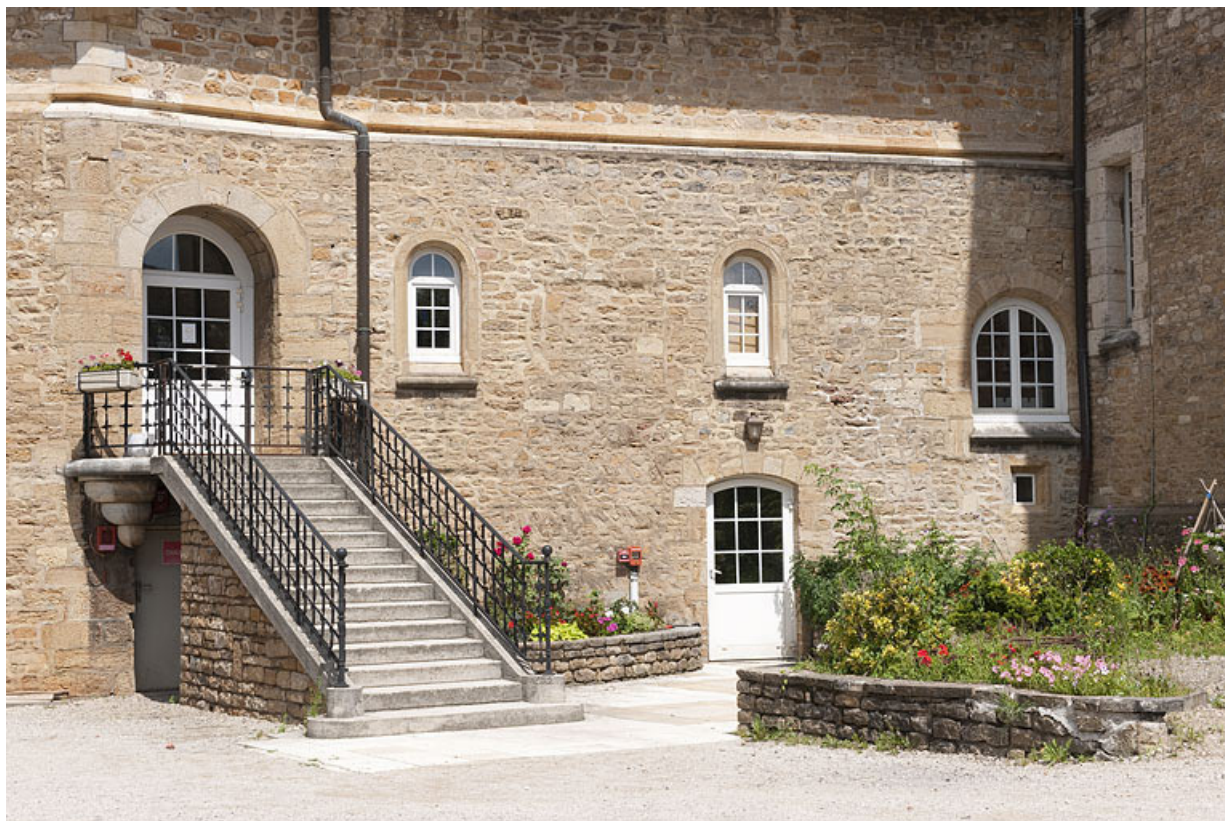
Bâtiment (C), escalier côté cour.
