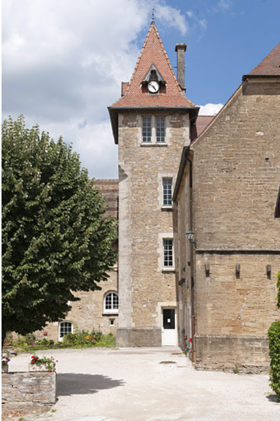
Bâtiment (C), vue de la tour d'escalier.
