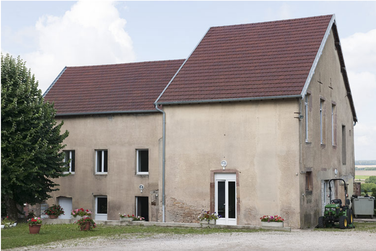
Bâtiment (B), vue d'ensemble depuis la cour.
