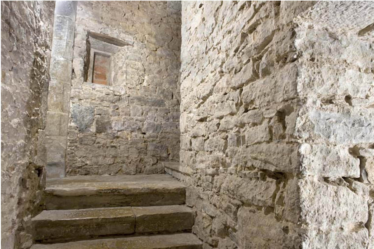
Escalier dans-oeuvre desservant les étages.
