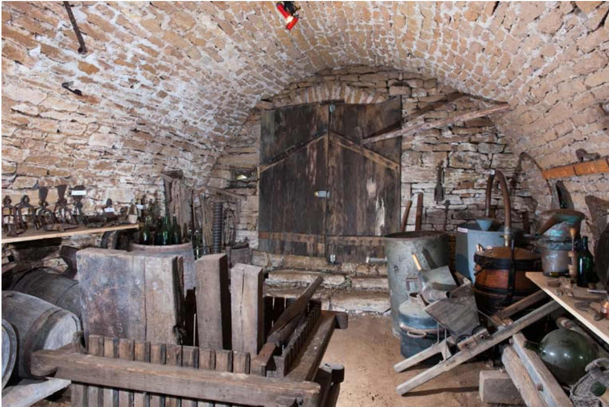
Vue générale de la cave depuis l'entrée.
