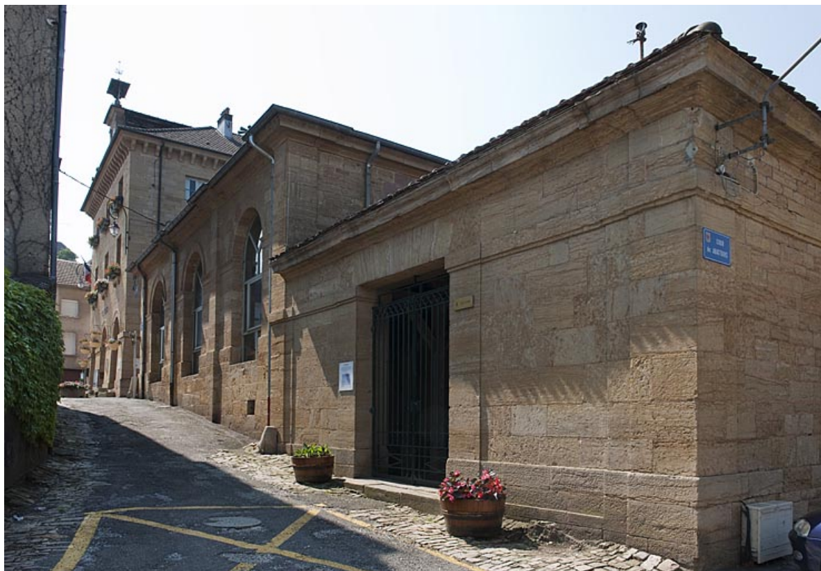
Façade rue du Lavoir.
