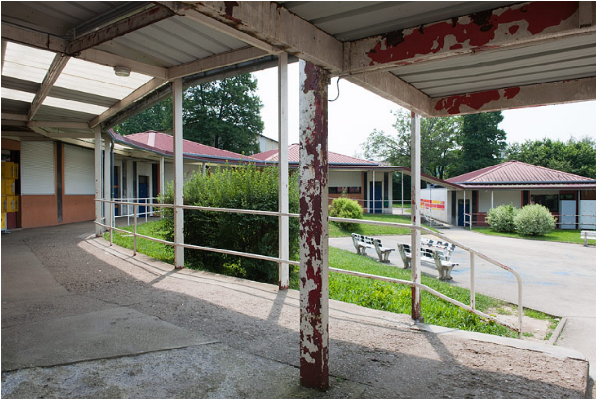
Vue générale de la galerie couverte.
