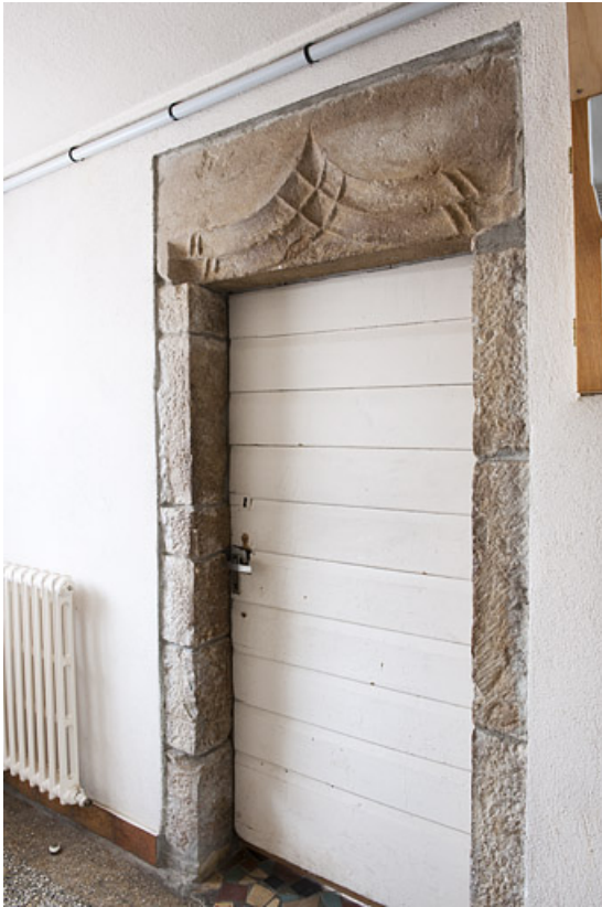
Intérieur : baie conduisant à l'ancienne grange.
