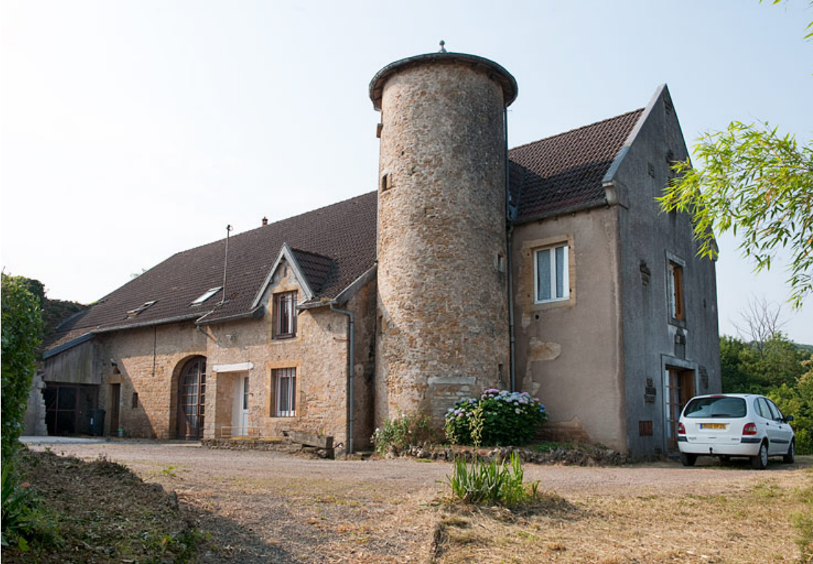
Façade antérieure, vue de trois quart droit.
