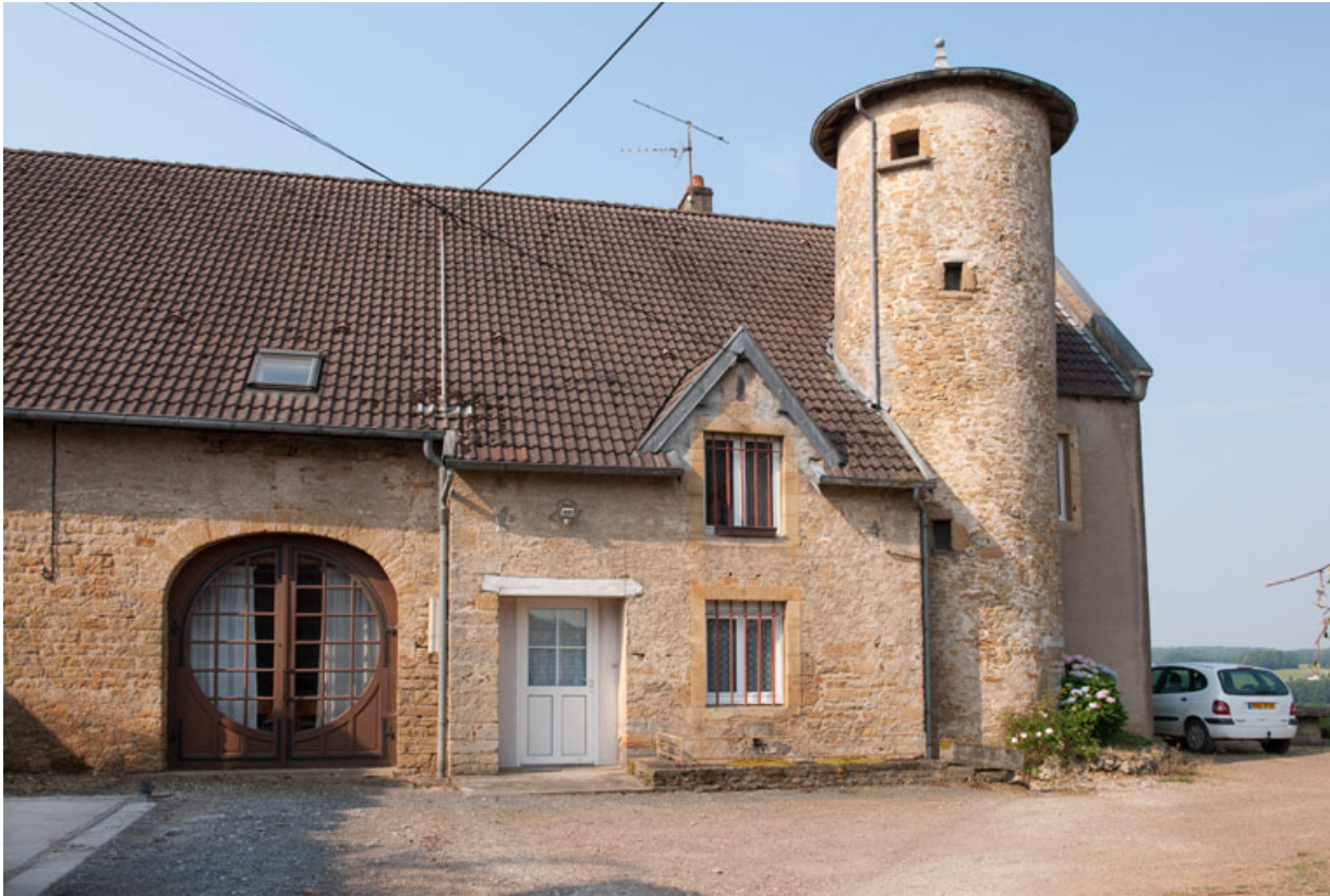
Façade antérieure vue de trois quart gauche.
