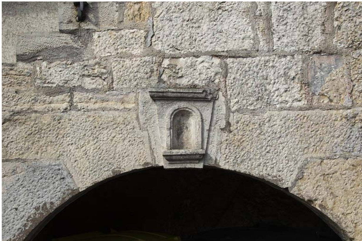
Détail d'une niche : 72 rue du Faubourg Rivotte.
