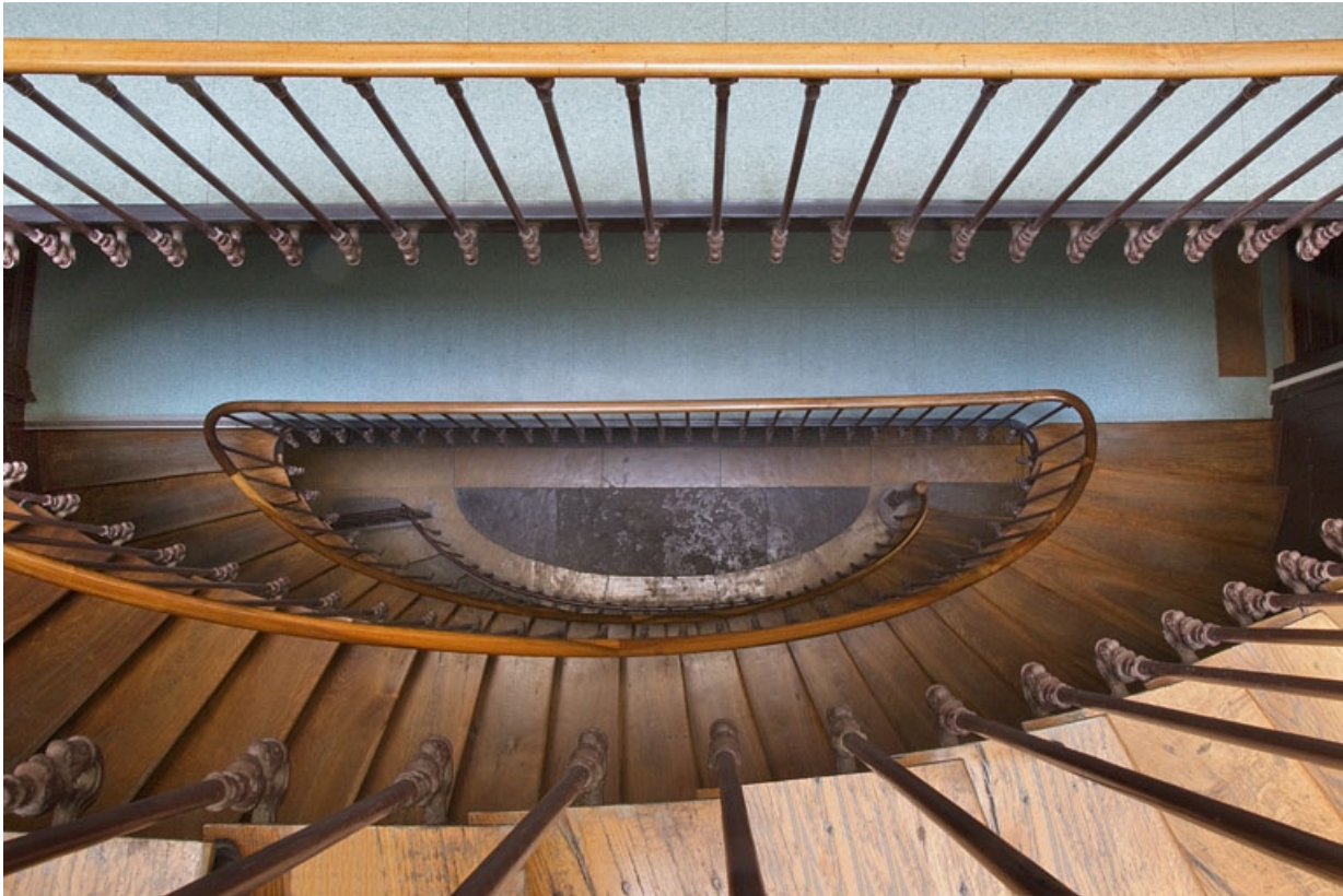
Intérieur, escalier : vue plongeante.
