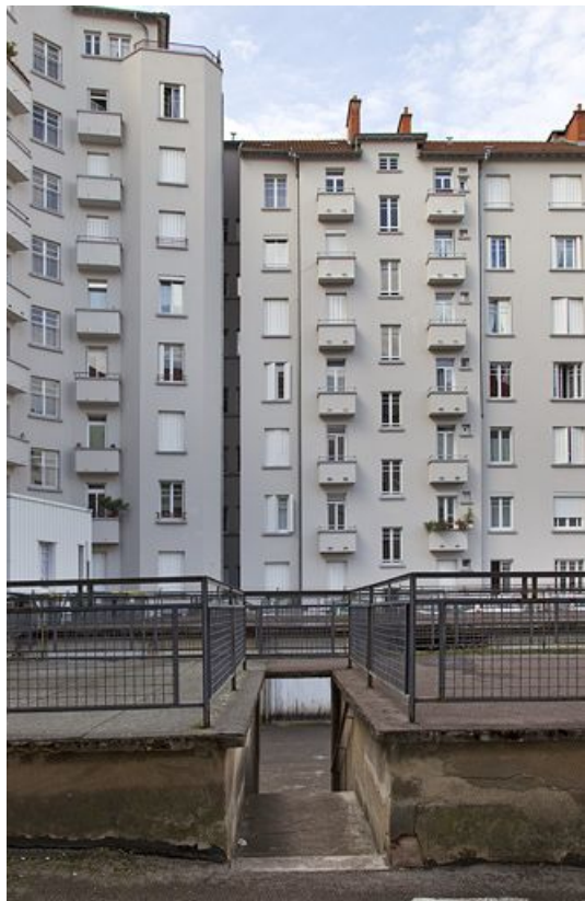
Cour des garages, vue latérale rapprochée.
