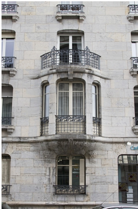
Façade latérale gauche : détail du bow-window.
