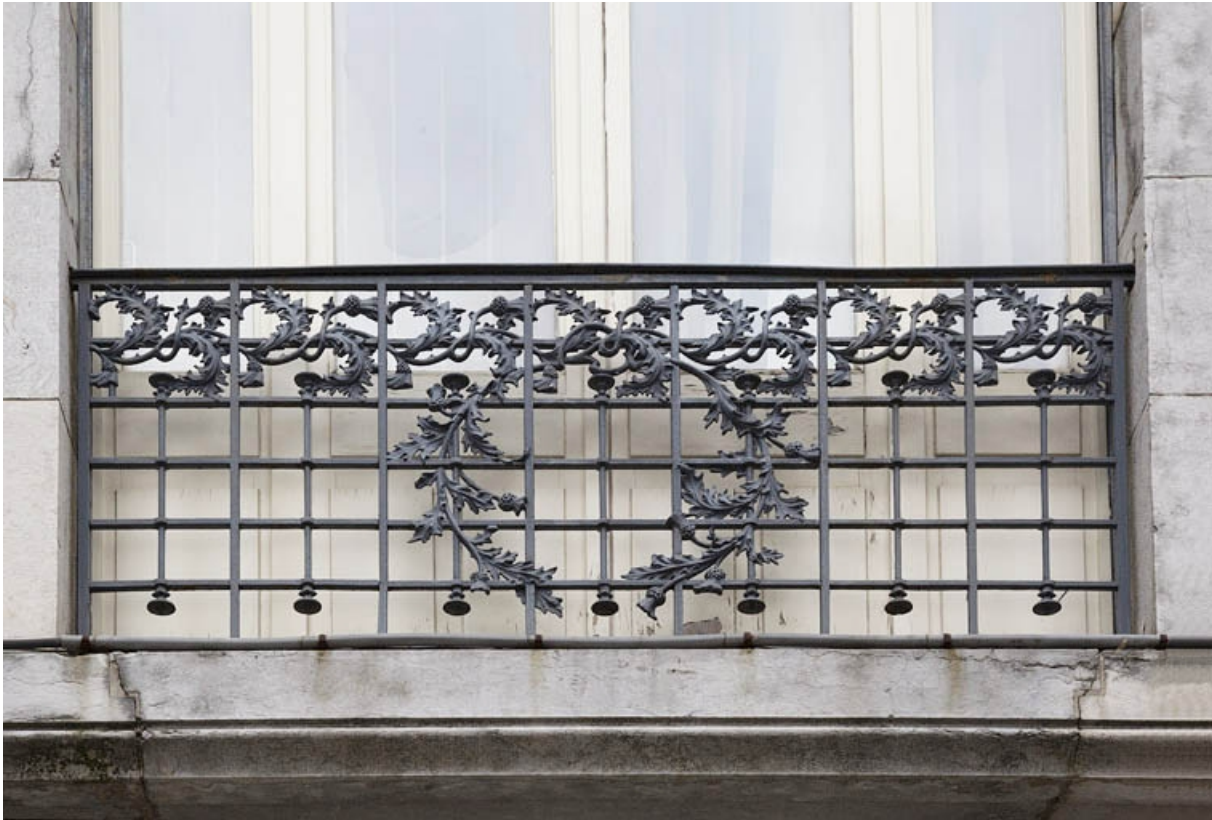
Détail du balcon d'angle du premier étage.
