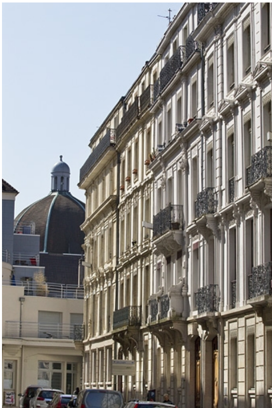
Vue d'ensemble dans l'alignement de la rue.
