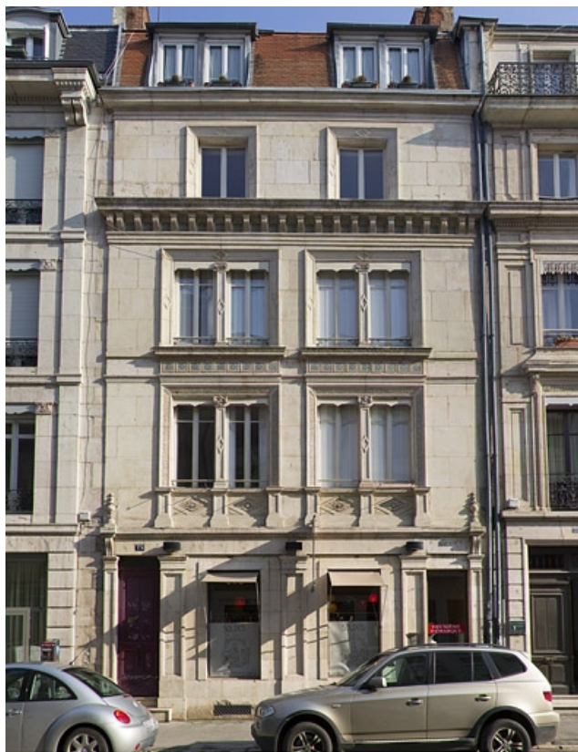
Façade antérieure, de face.
