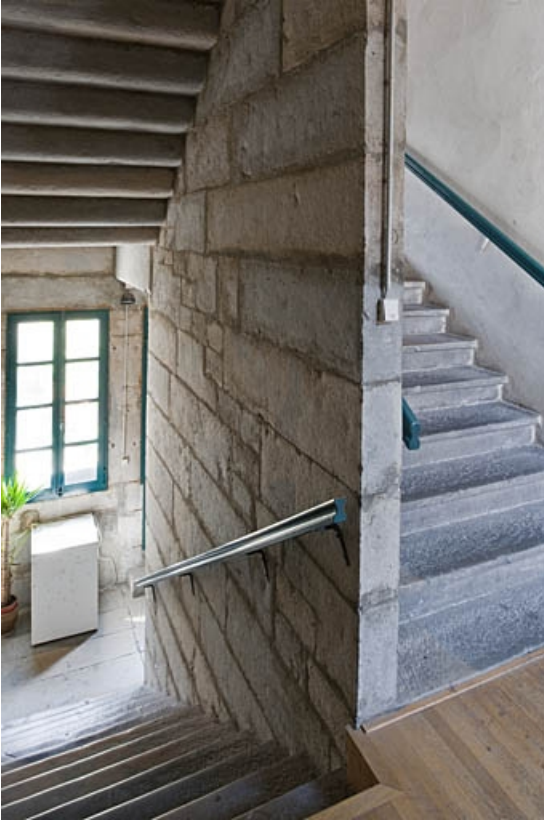
Intérieur : escalier principal en pierre.
