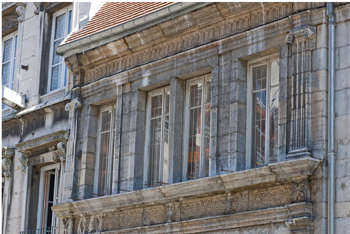
Façade sur rue : premier étage, partie gauche.
