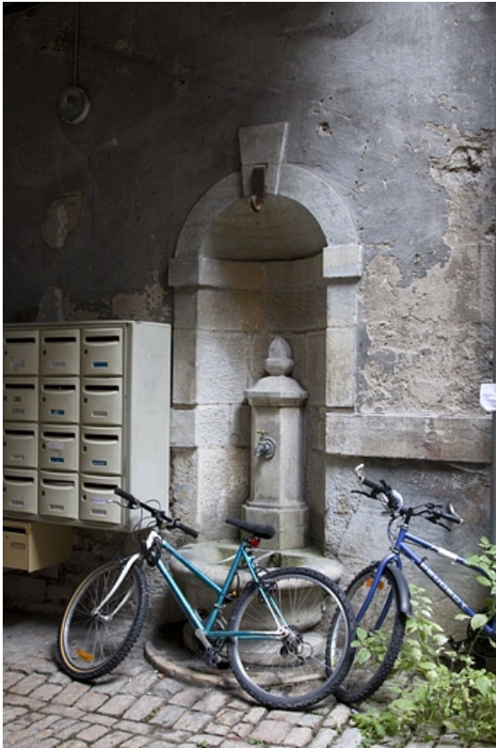
Cour : détail de la borne fontaine.
