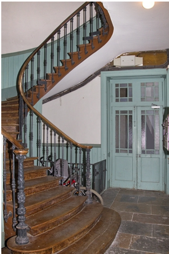
Intérieur : vue d'ensemble de l'escalier.
