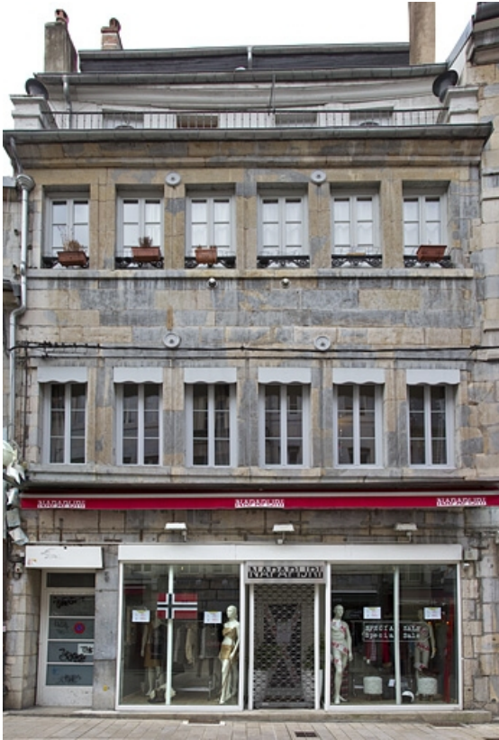
Logis principal, façade antérieure : de face.
