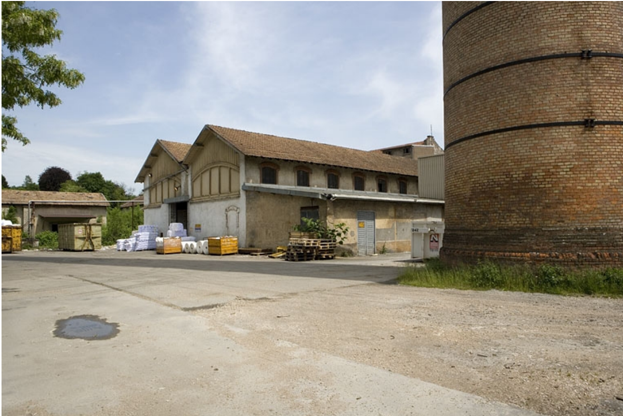
Entrepôt industriel. Pignon ouest.
