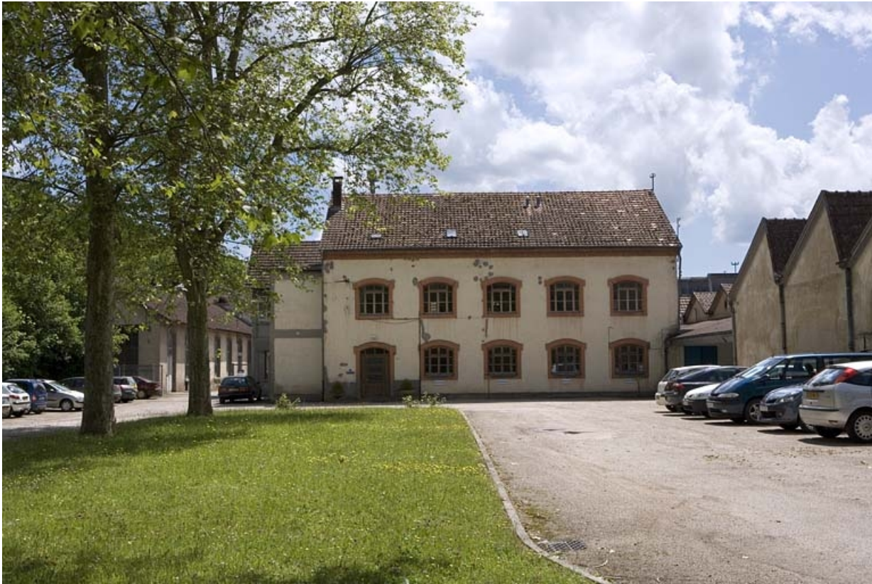
Bureaux. Façade antérieure.
