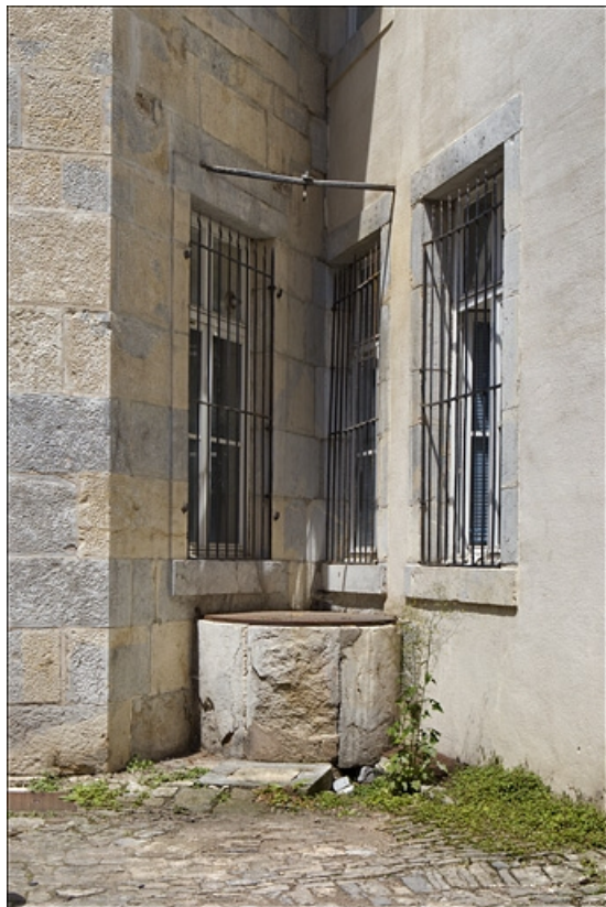
Deuxième cour : détail du puits.
