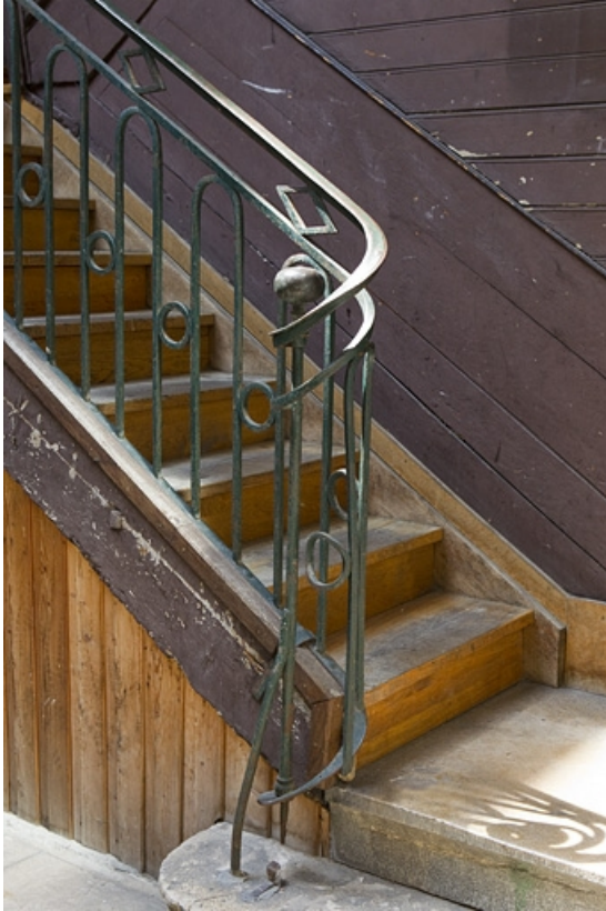
Détail du départ de rampe de l'escalier à cage ouverte.
