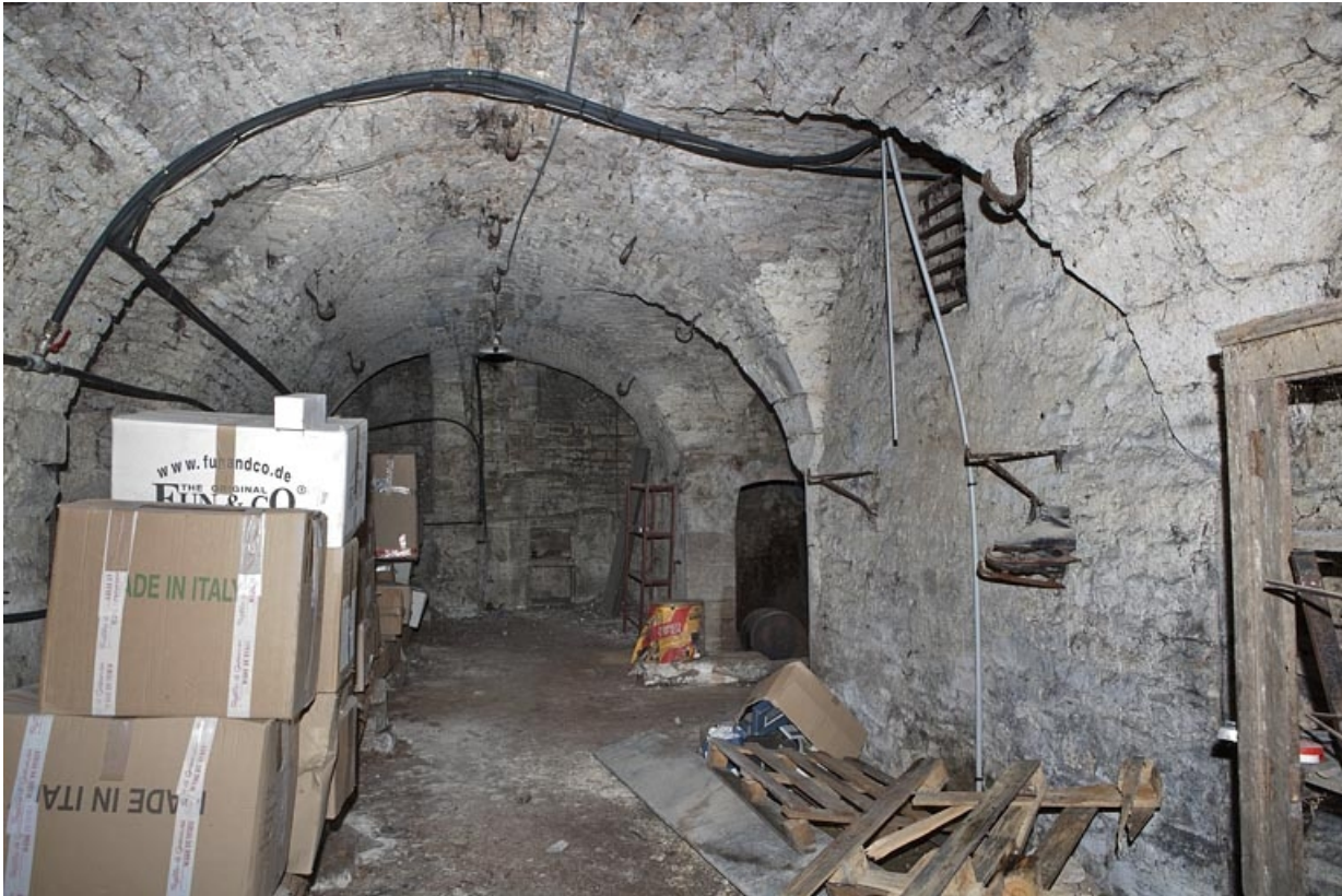
Logis principal, sous-sol : cave A depuis l'entrée.
