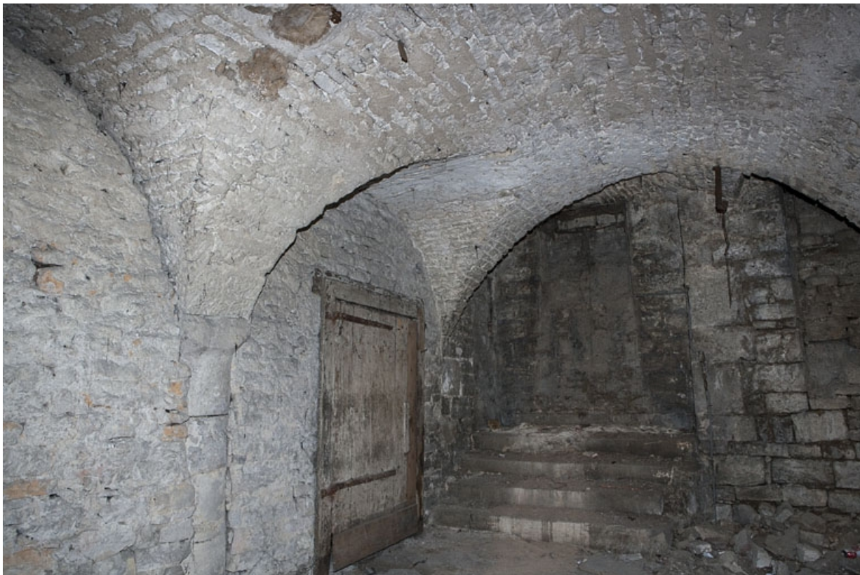
Logis principal, sous-sol : cave C.
