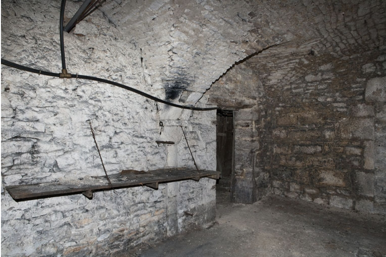
Logis principal, sous-sol : cave C.
