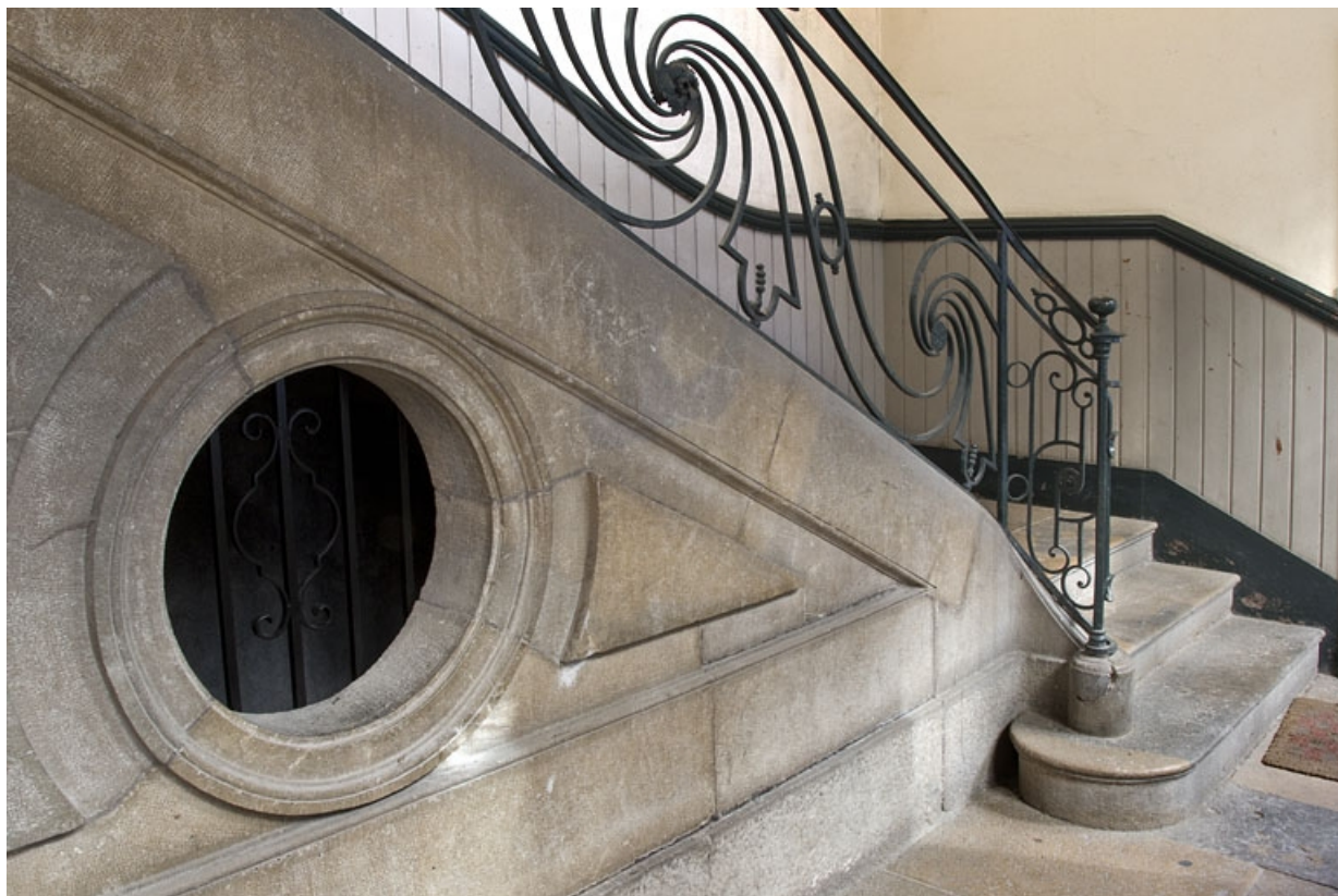
Logis principal : détail du départ de l'escalier.
