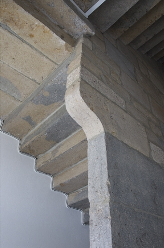
Partie droite : détail de l'escalier en pierre rampe sur rampe.
