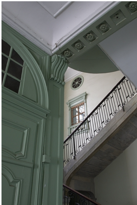
Intérieur, escalier d'honneur : vue depuis le rez-de-chaussée.
