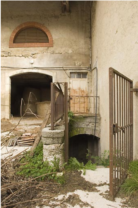
Habitation : façade postérieure, descente de cave.
