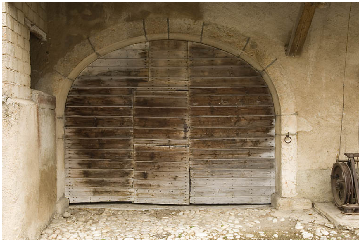
Façade antérieure : porte de la grange.
