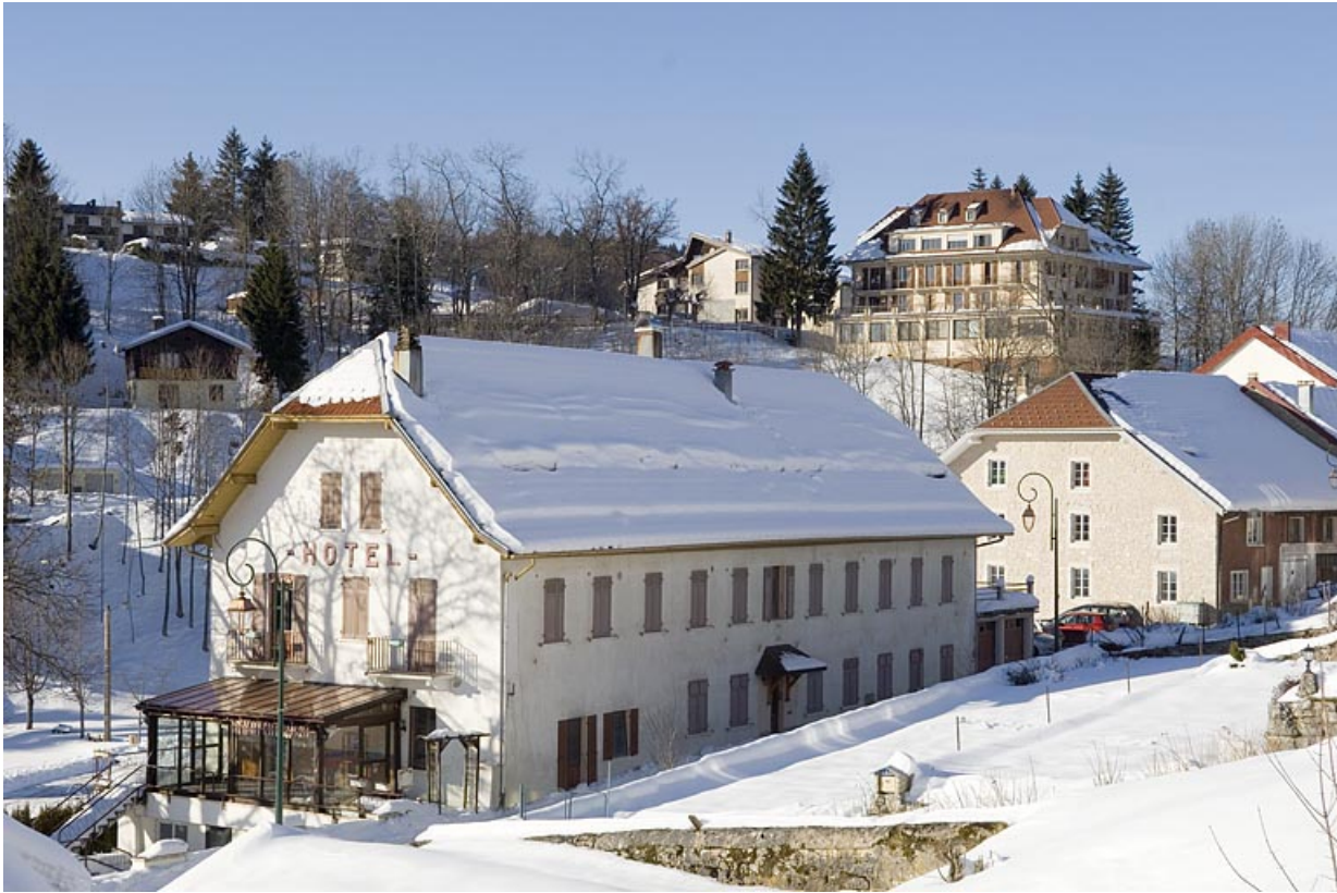
Façades antérieure et latérale gauche.
