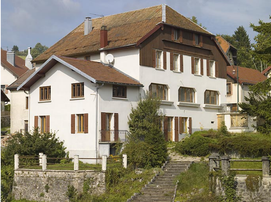
Façade postérieure et façade latérale gauche.
