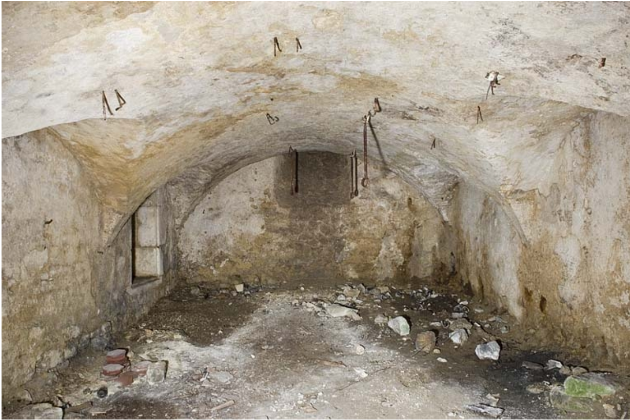
Vue générale du sous-sol.
