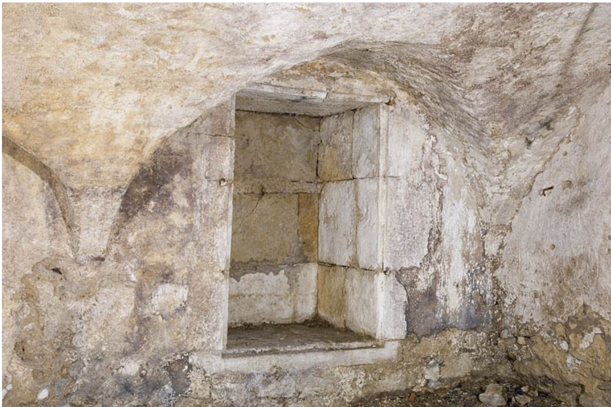
Sous-sol : détail, niche.
