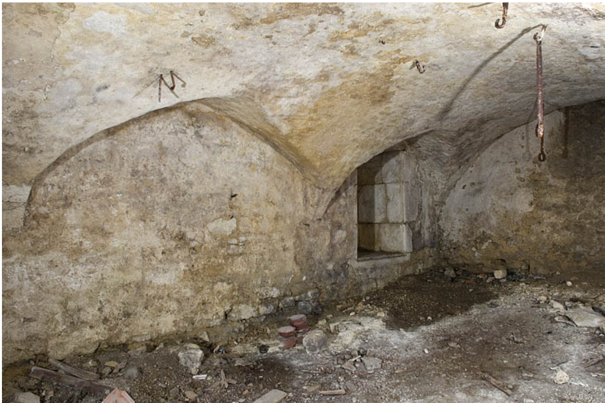
Sous-sol, vue de trois quart gauche.
