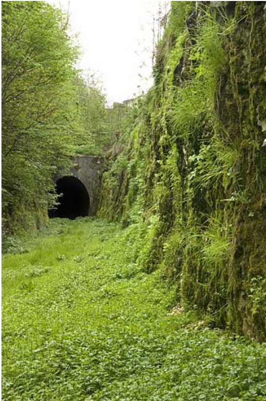
Tunnel et tranchée.
