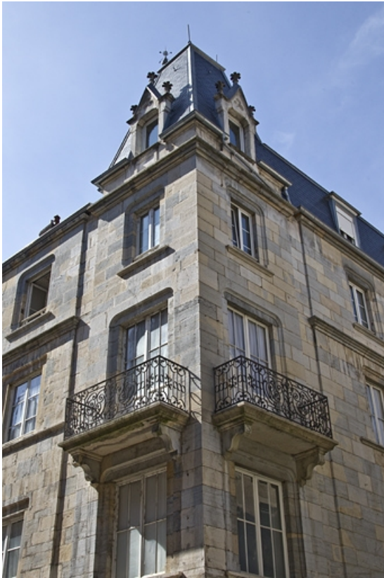
Vue rapprochée de l'angle du logis principal.
