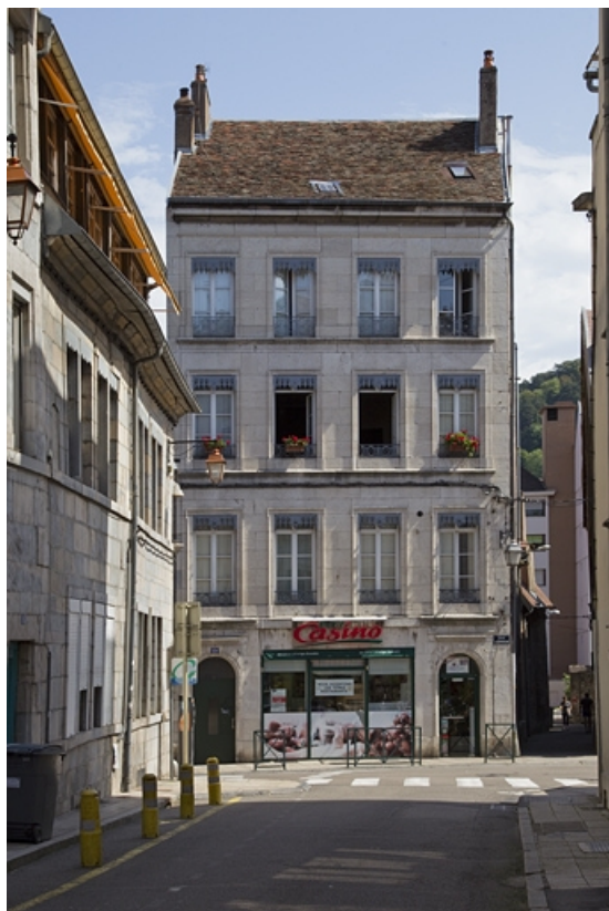
Logis principal : façade antérieure, de face.
