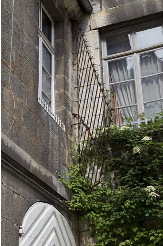
Cour : détail d'une grille de protection.
