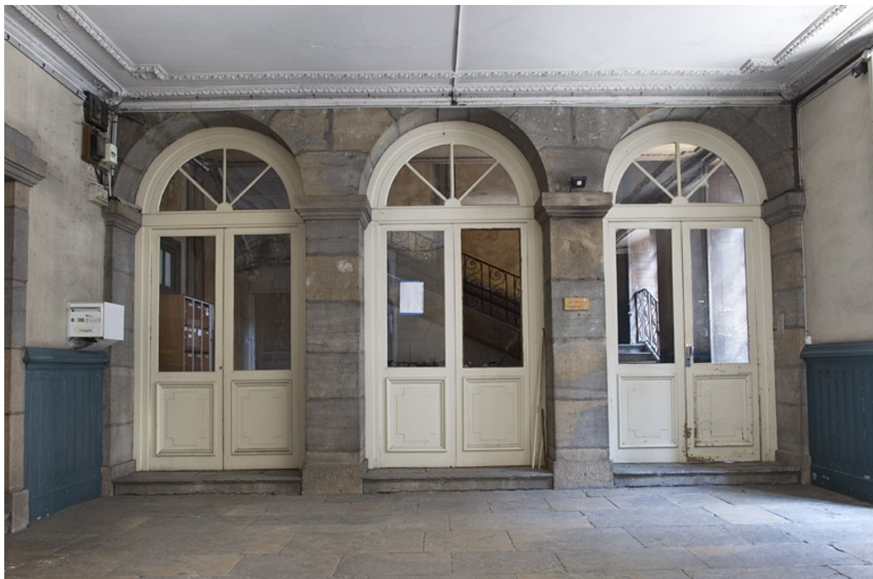
Vue de l'entrée de l'escalier, de face.
