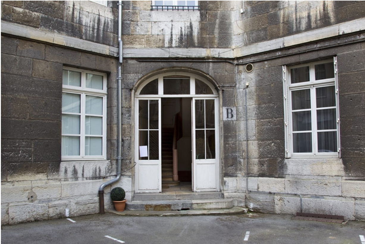
Logis principal : entrée secondaire de l'aile droite.
