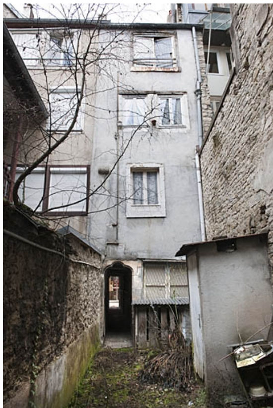
Logis principal : façade postérieure, de face.
