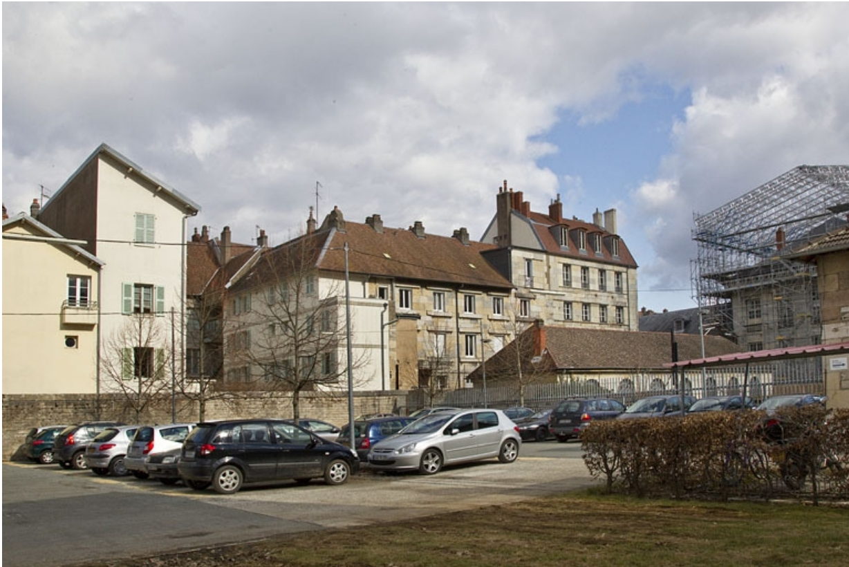
Vue d'ensemble éloignée de l'arrière de l'édifice.
