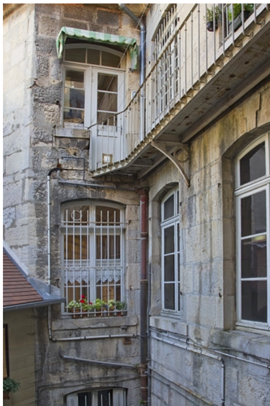
Logis : détail de la façade postérieure.
