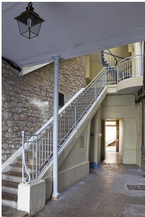
Logis principal : vue d'ensemble de l'escalier.
