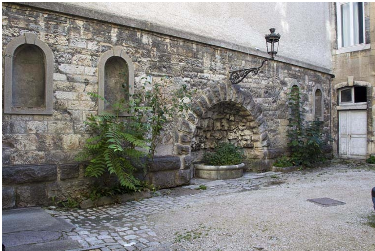
Mur gauche de la cour : vue d'ensemble.
