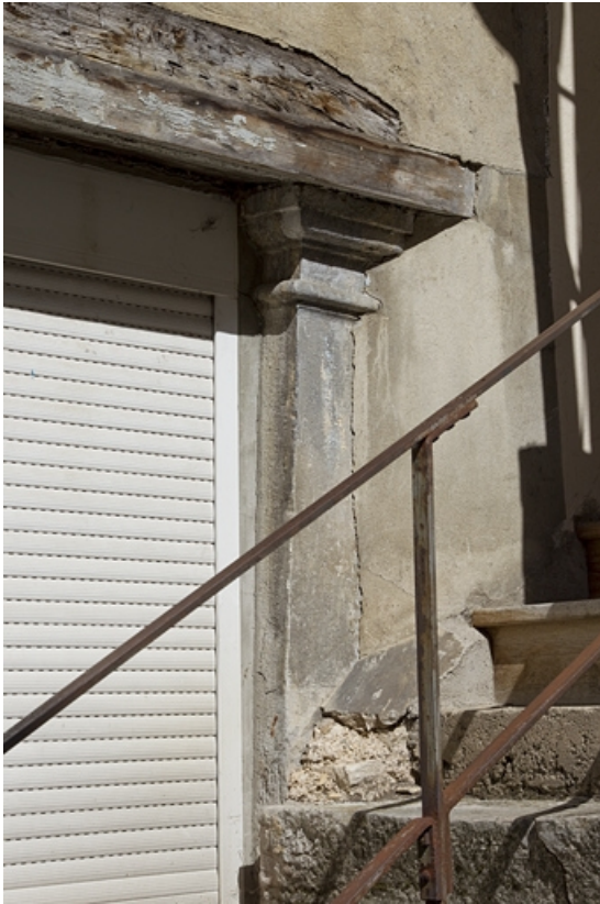
Façade postérieure du premier logis secondaire, vestiges supposés d'un portique : détail d'un chapiteau toscan. 25, Besançon, 37 rue Renan, lieudit : îlot Cingle
