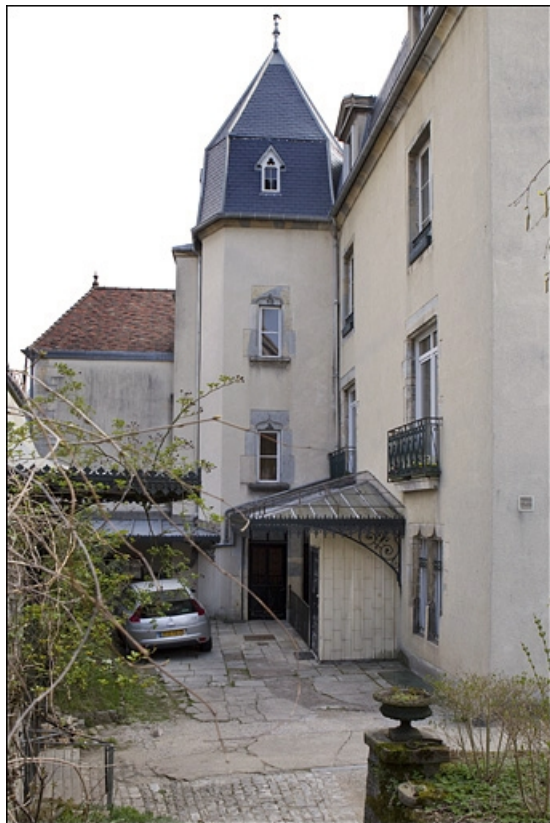
Logis principal : détail de la tour d'escalier.
