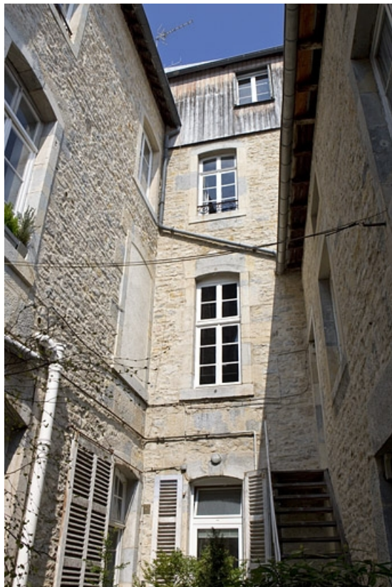
Vue des façades donnant sur l'ancienne basse-cour.
