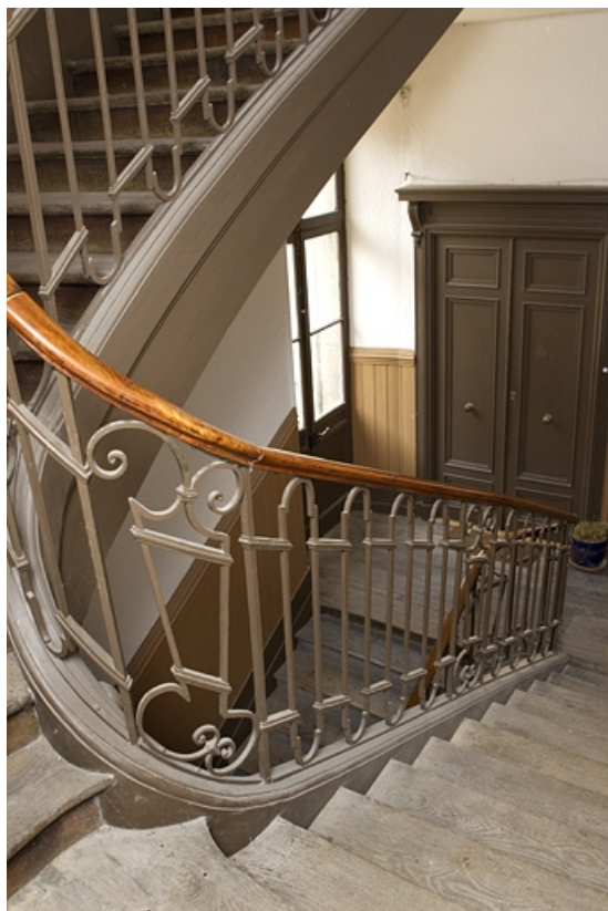
Vue de l'intérieur de l'escalier.
