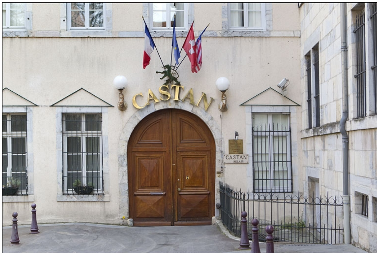
Vue du portail d'entrée sur rue.
